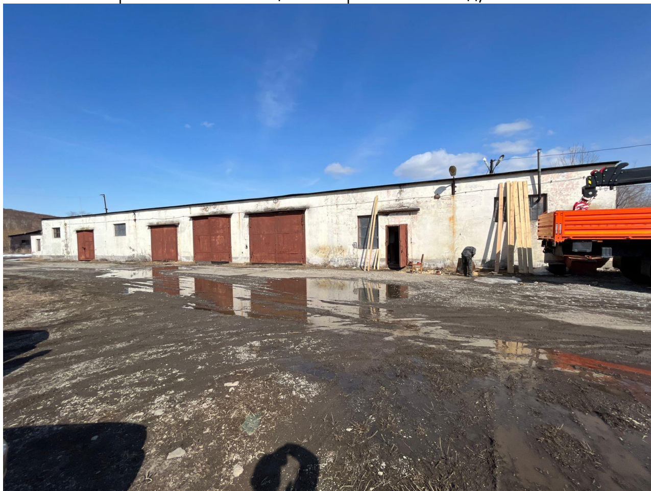
Изображение 4. Общій вид фасада здания в осях А/1-8
