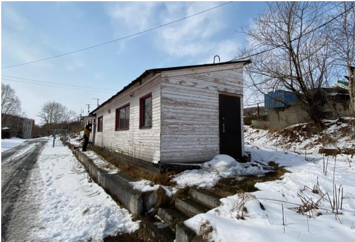
Изображение 38. Общий вид фасада здания обеспечения ремонтно-механической мастерской в осях 4/А-Б
