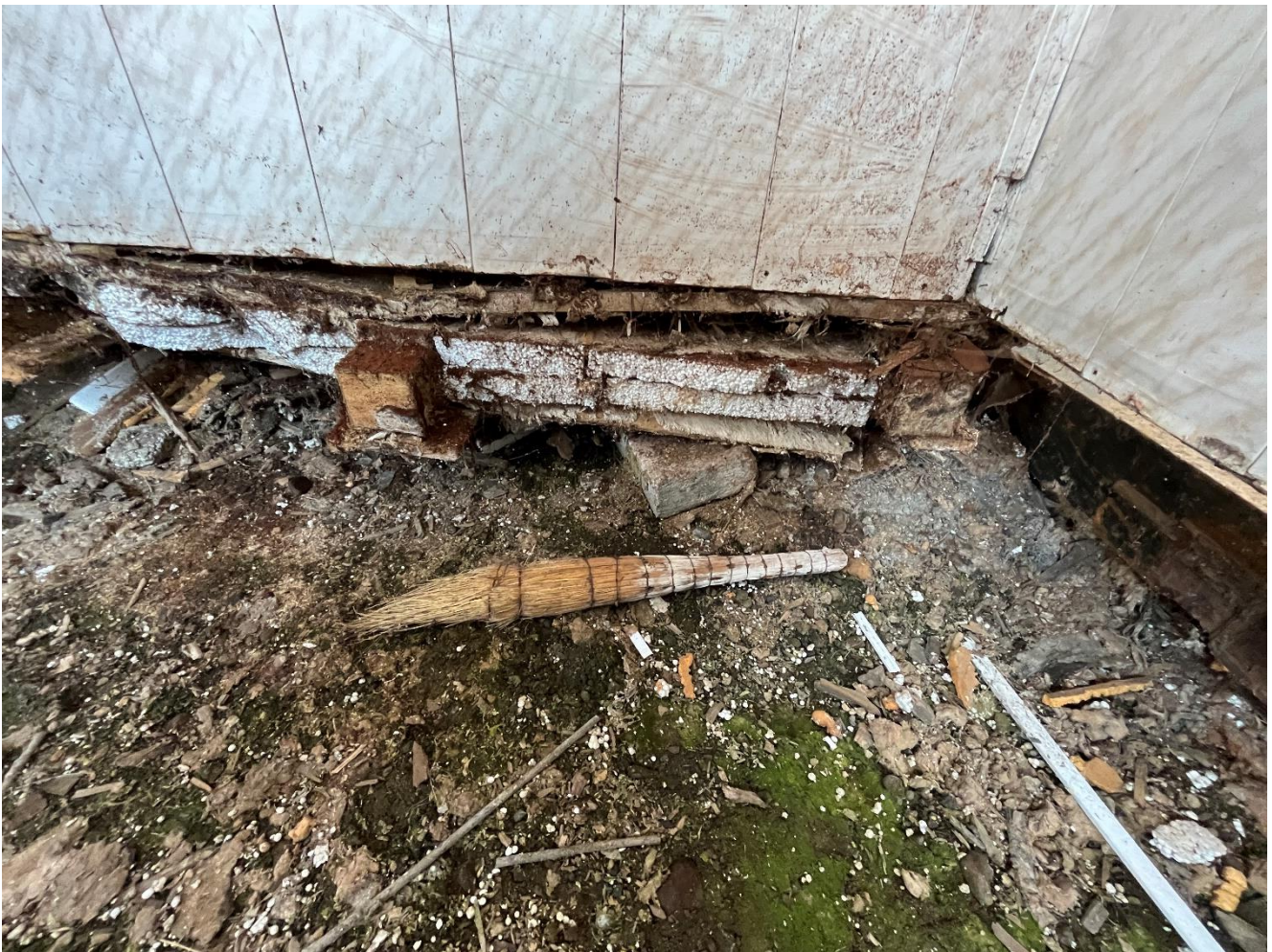
Изображение 40. Отсутствие фундамента, устройство полов на металлической раме, несущие конструкции пола выполнены из бруса 100x100 с подшивкой из фанеры, в полости между фанерами утеплитель пенополистирол
