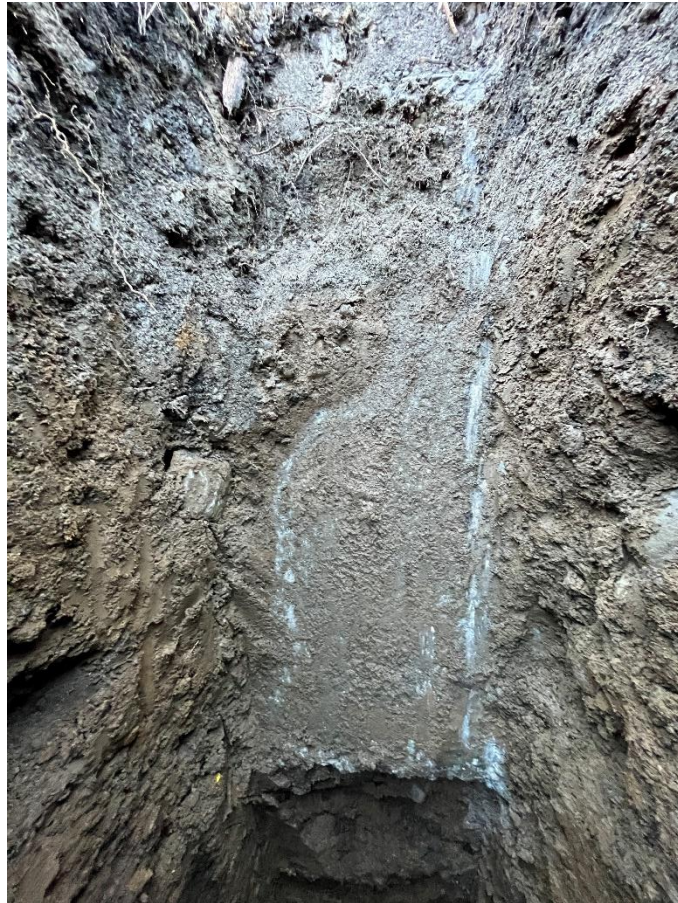
Изображение 17. Устройство шурфа № 4 в осях 21-/Д
