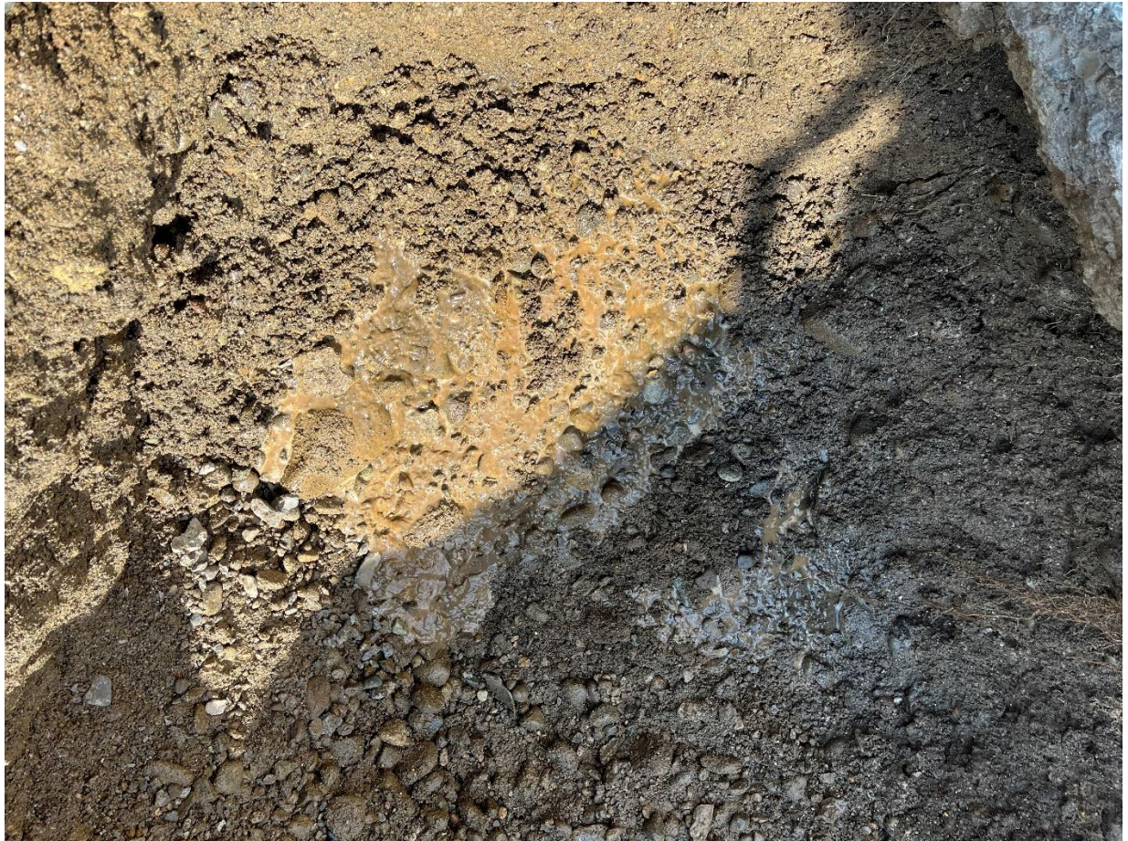
Изображение 5. Грунтовые воды на глубине 1.3 м при устройстве шурфа №1
