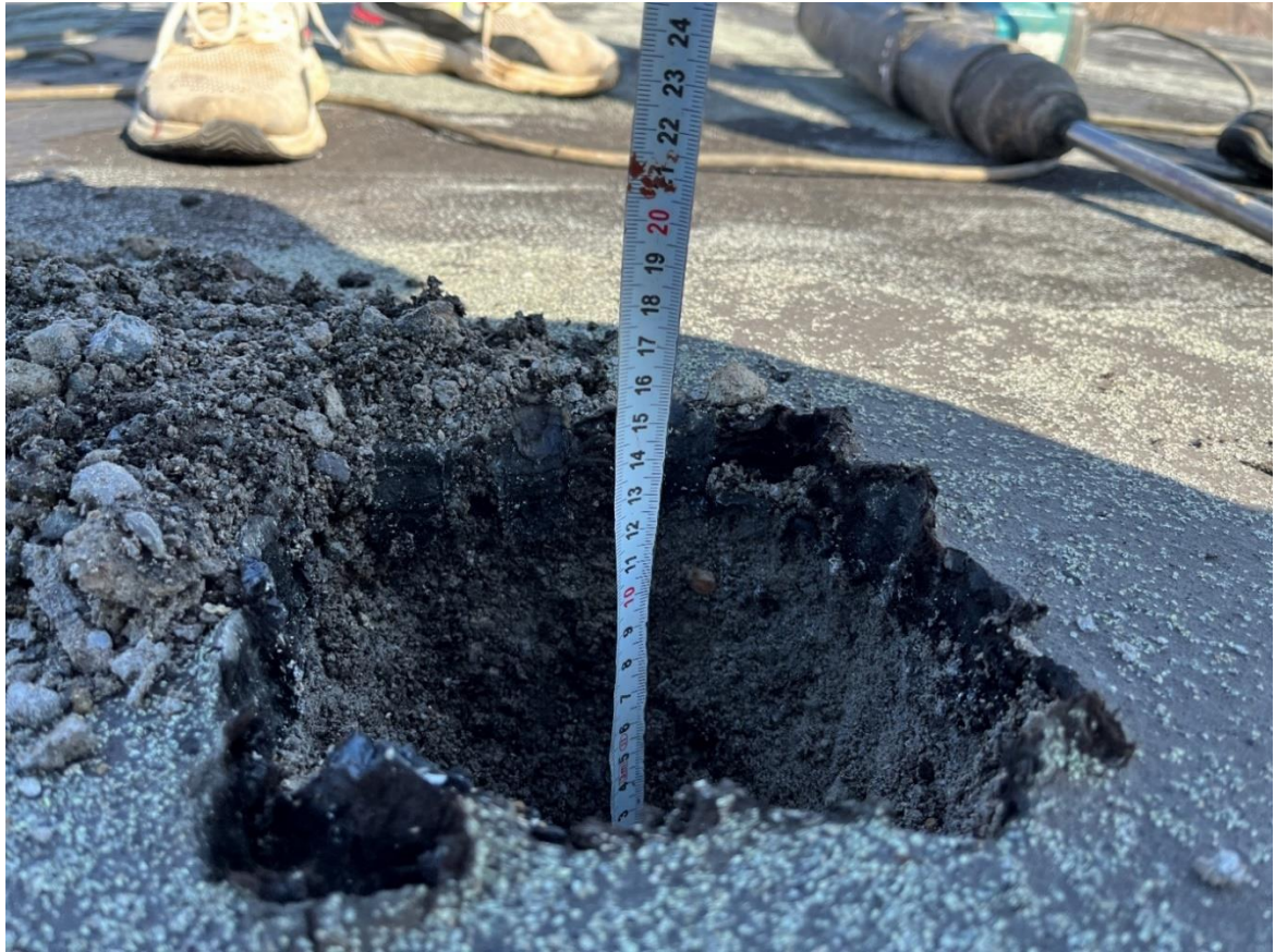
Изображение 23. Определение состава пирога кровельного здания ремонтно-механической мастерской
