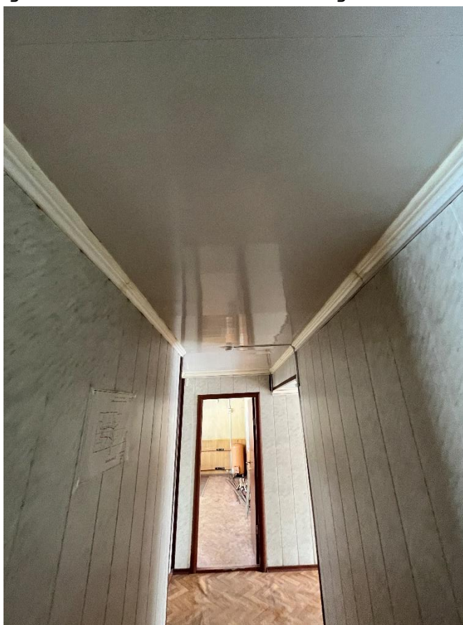
Изображение 42. Искривление дверных проемов стенах
