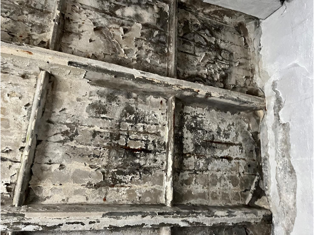
Изображение 21. Разрушение защитного слоя бетона плит перекрытия в помещении №15
