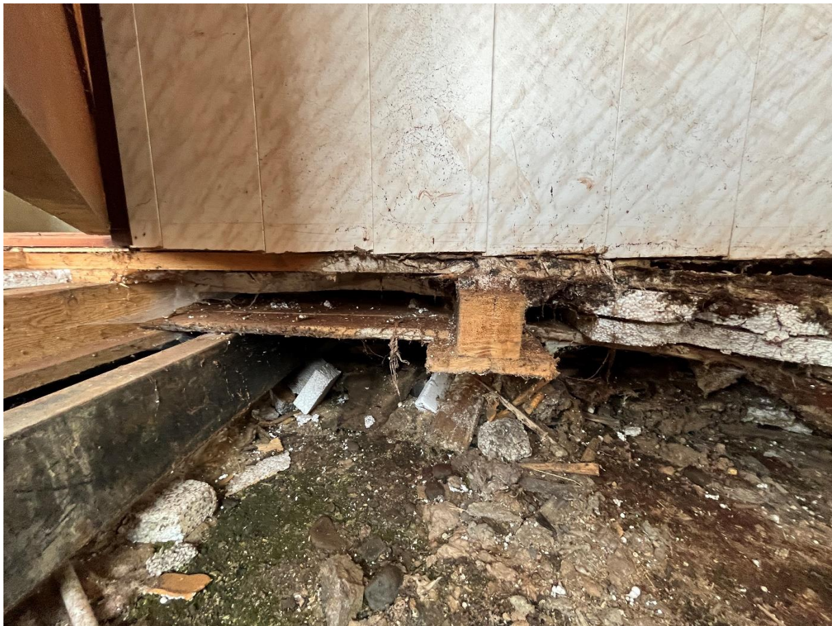
Изображение 41. Отсутствие фундамента, здание установлено на металлическую раму. Рама установлена на отдельные куски из блоков
