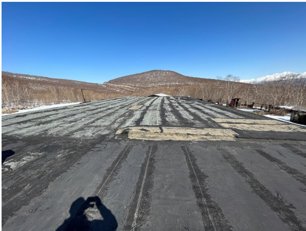
Изображение 26. Общій вид кровли в осях 4/А-Д
