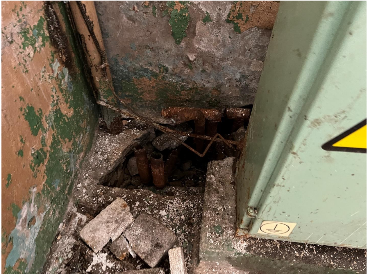
Изображение 9. Ввод сети водоснабжения, 2д
