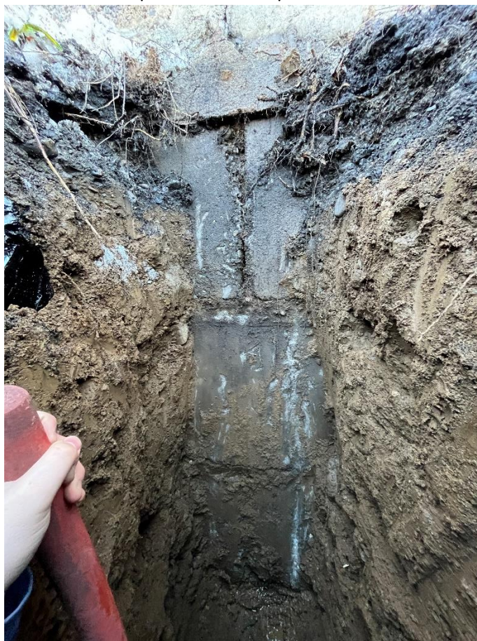
Изображение 16. Устройство шурфа №3 в осях 2-3/Д. В качестве фундамента использованы блоки ФБС
