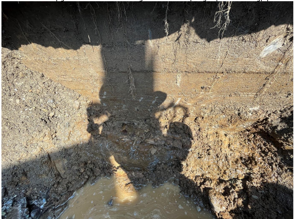
Изображение 6. Отсутствие гидроизоляции фундамента в шурфе №1, грунтовые воды расположены ниже подошвы фундамента
