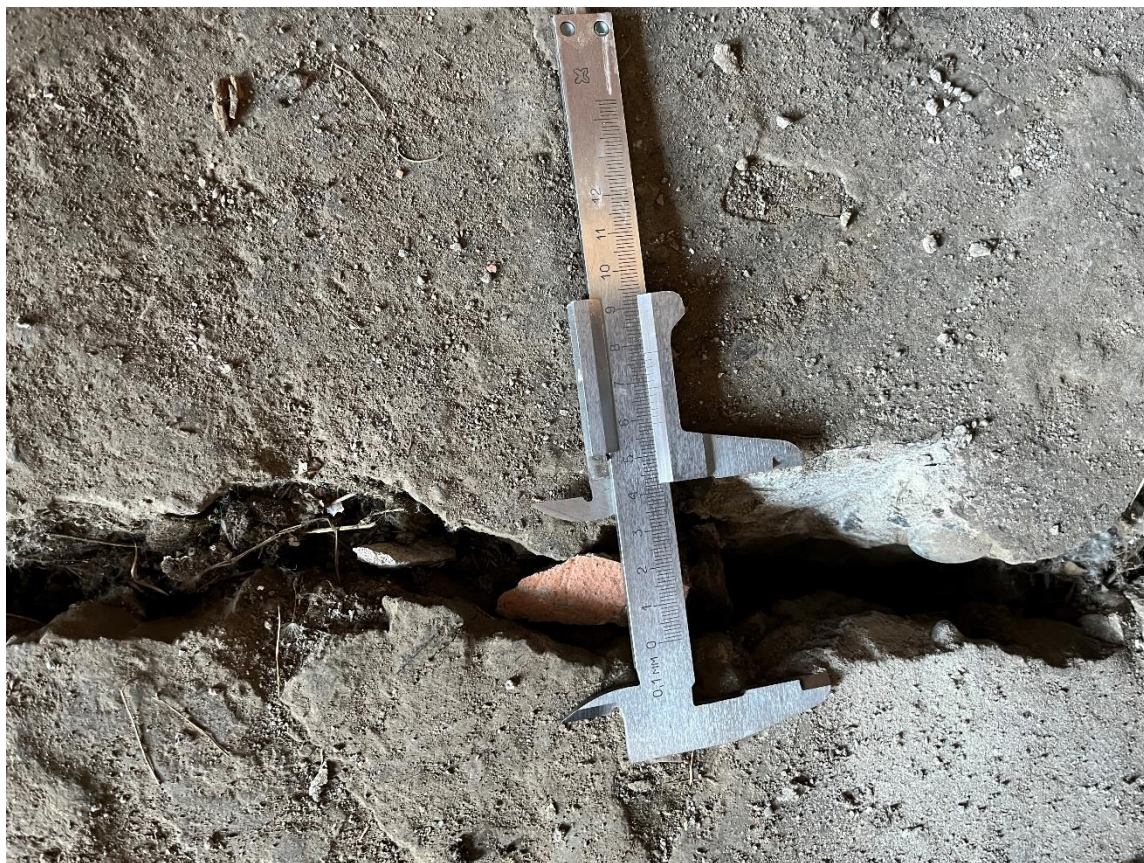
Изображение 32. Образование сети трещин по бетонному полу. На штангенциркуле показание 56 мм
