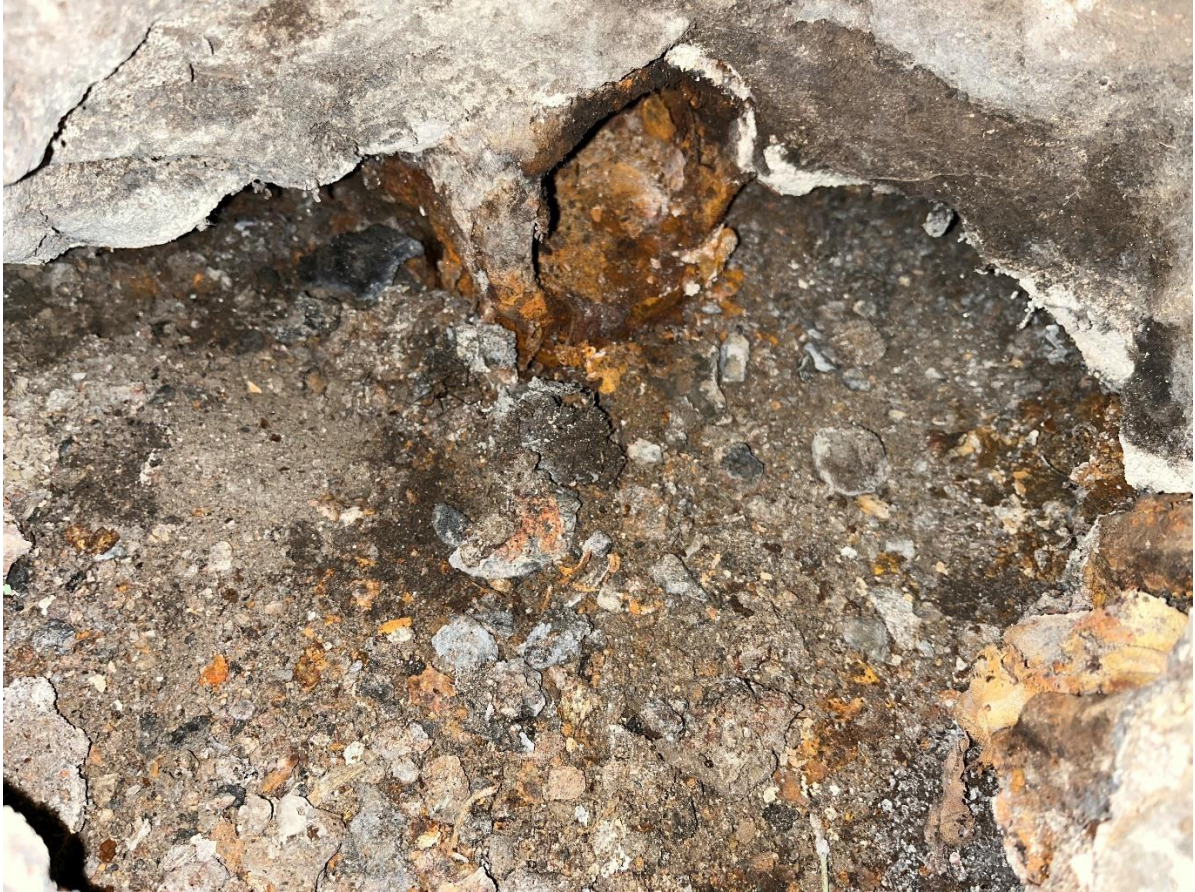
Изображение 11. Внутренние сети водоотведения в помещении №7. Трубы имеют следы глубокой коррозии
