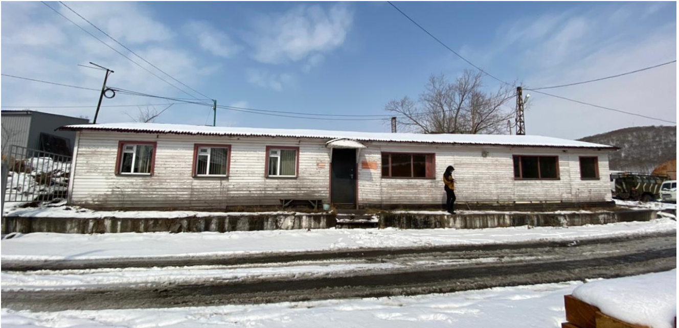
Изображение 37. Общий вид фасада здания обеспечения ремонтно-механической мастерской в осях А/1-4
