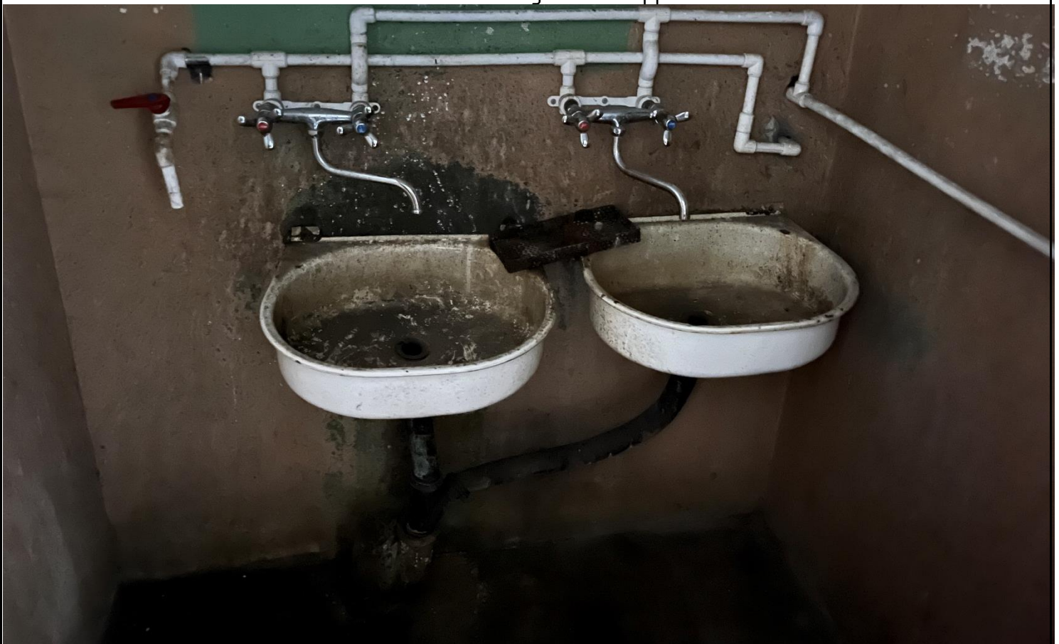
Изображение 12. Внутренние сети водоснабжения и сантехнические приборы в помещении №7
